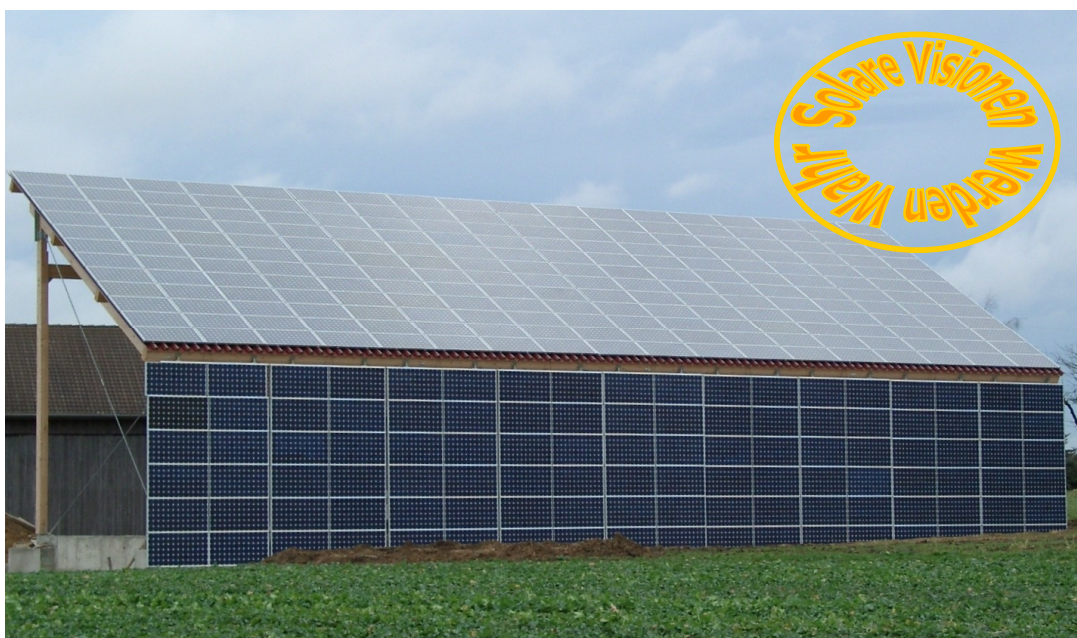
Bild: 59 kWp Photovoltaikhalle mit Dach und Fassadenanlage, die der Sonne nachgestellt wird.
